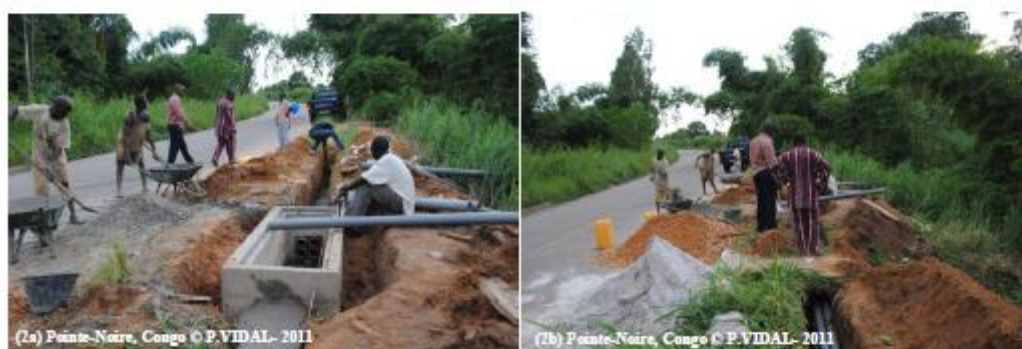
Photo 2 – Congo Télécom inspecte la bonne tenue des travaux entre le point d’atterrage du câble et la station terminale
